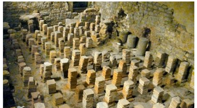
Pilaren waarop de vloer van de woning rustte
